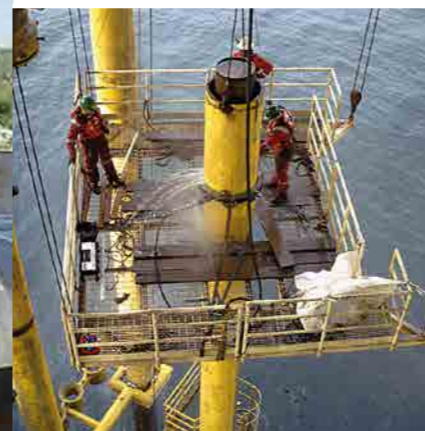
> Обслуживание нефтебуровой платформы с помощью станка для резки PROTEM серии TT
